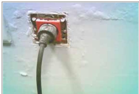
Humedad en pared de la sala que afecta a la instalación eléctrica.
